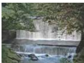
霧島神水峡の戸崎橋人工滝
